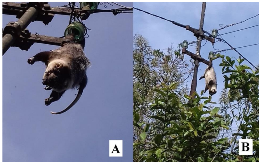
Figura 2. Registros fotográficos do marsupial Didelphis albiventris encontrado electrocutado no poste na zona rural de Soledade de Minas, sul do estado de Minas Gerais, sudeste brasileiro.
